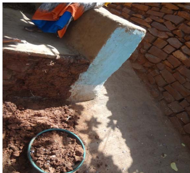
Fig. 4: Ongoing Repairs at Dado.
